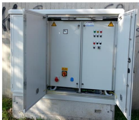
Innentür, Türfeststeller, Kontaktschalter und Steckdose
